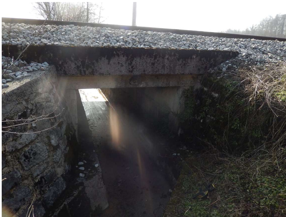
Slika 1: Pogled na objekt. Vidni so kamniti krilni zidovi ter oproniki in AB preklada. Ograje ni.
